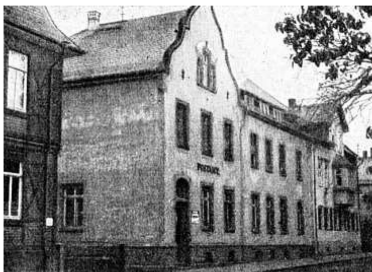
Postgebäude (Alicestraße) von 1901 bis 1929
