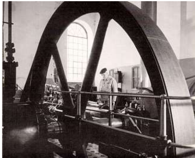
Kraft- und Kühlzentrale der Brauerei
