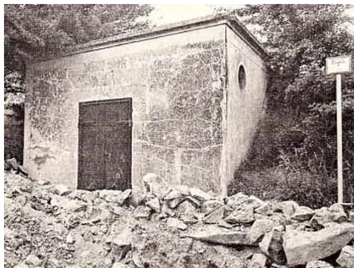
Abb. 2: Hochbehälter der früheren Niederdruckzone
