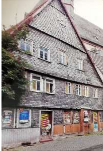
Abb. 2: Äußerer Zustand 2021 Foto: Norbert Hansen
