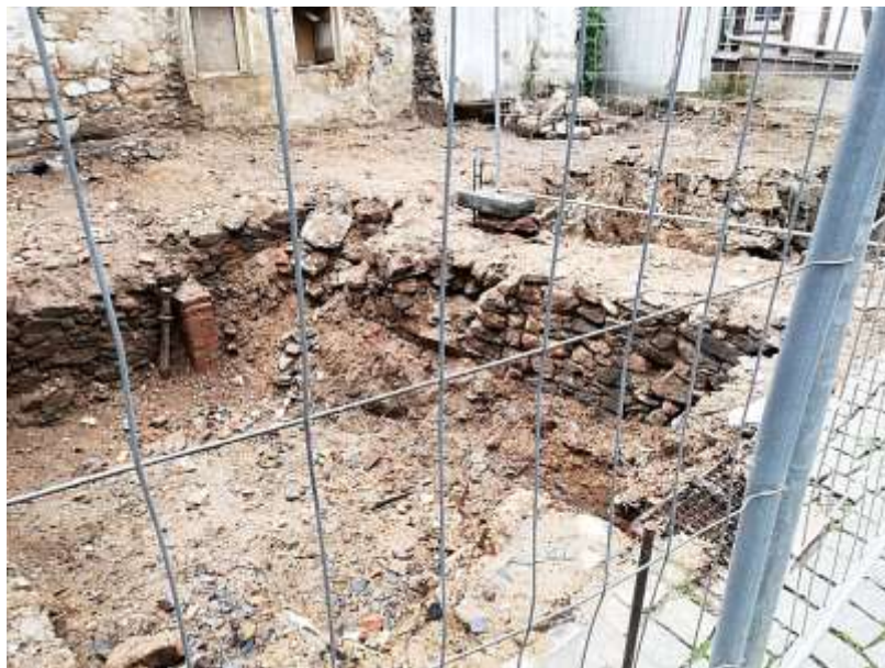
Abb. 6: Blick in die niedrigen Kellerräume nach Ende des Gebäudeabbruchs Foto: Norbert Hansen
