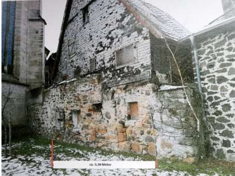
Abb. 5: Historische rückwärtige Gebäudewand Foto: Norbert Hansen
